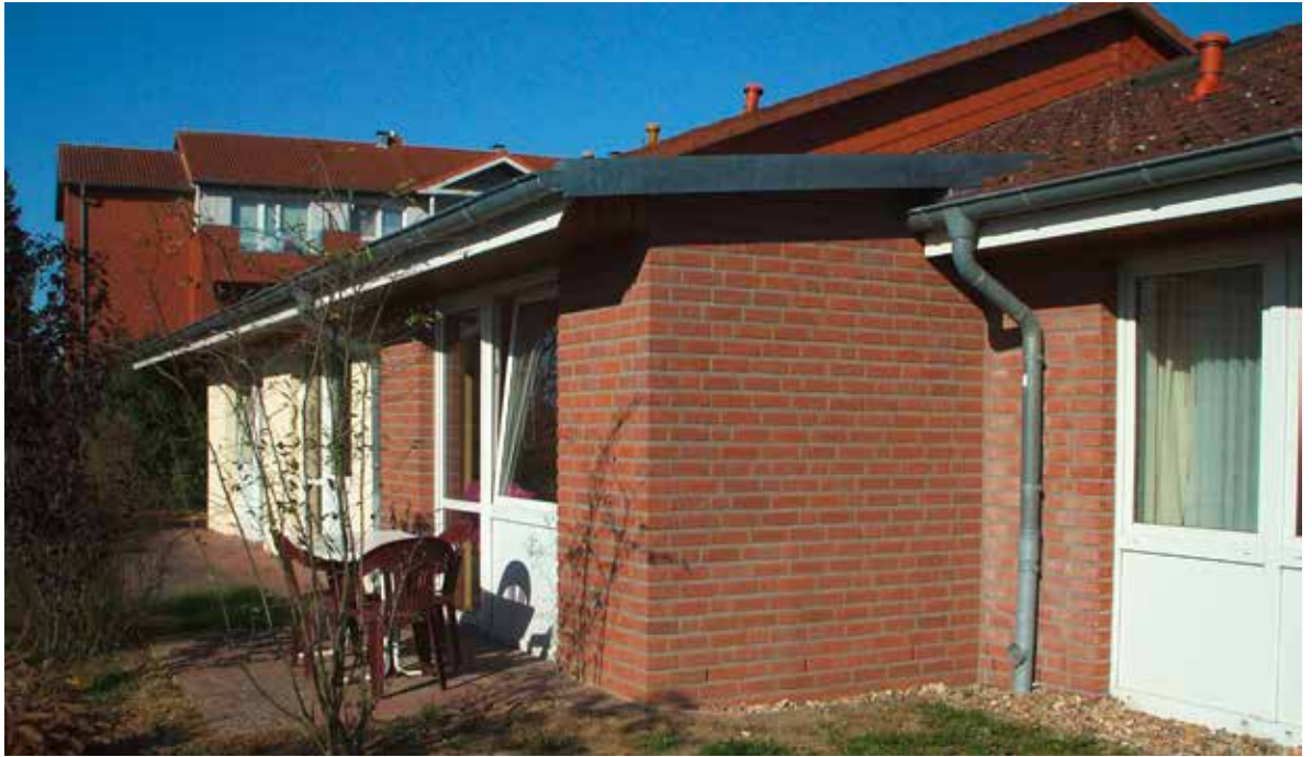
Nicht zu fassen! Sieht aus, als wenn er schon immer da gewesen wäre: der neue, kleine Anbau!
